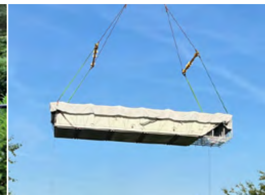
Mise en place du bassin MLine par grue.
