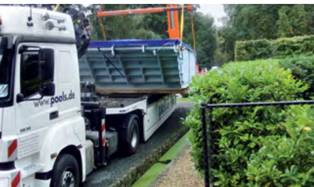
La piscine arrive entièrement carrelée à destination.
